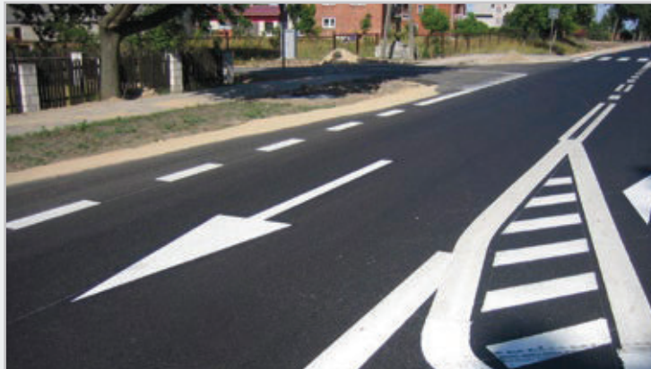
Fot. 1. Znakowanie drogi masą chemoutwardzalną
