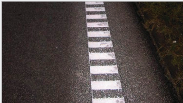
Fot. 1. Mikrokule Swarcolux P-21 świejące w czasie jazdy nocnej
