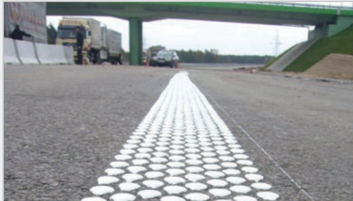
Fot. 1. Znakowanie strukturalne drogi masą Graviplast 200
